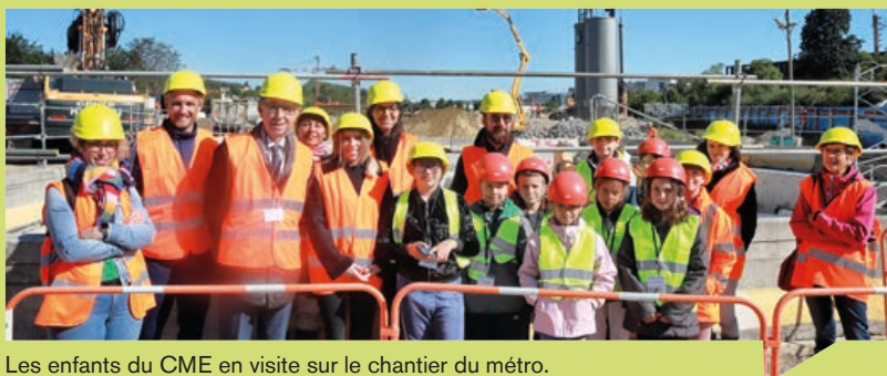
Les enfants du CME en visite sur le chantier du métro.
